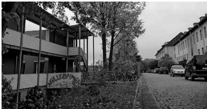
Flüchtlingswohnanlage zwischen ehem. „Ex.-Platz“ und Hannah-Vogt-Str., 2015
